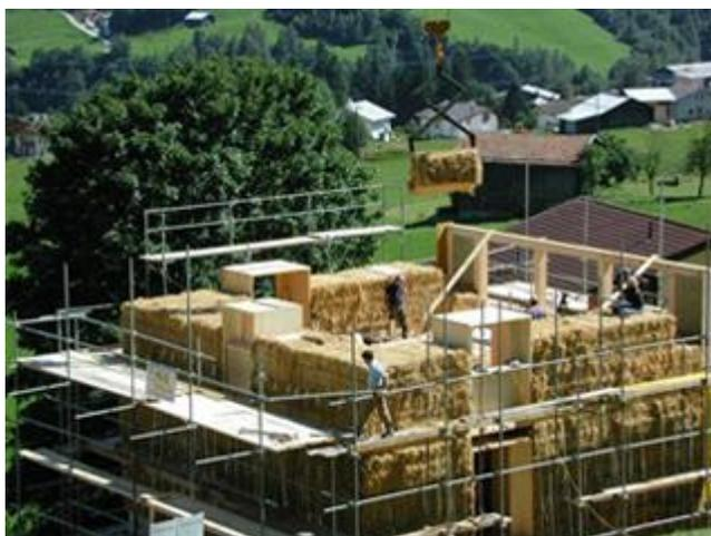
В одноэтажных домах соломенные тюки стандартной ширины (0,45 м) могут выполнять роль несущих конструкций. Строительство двух и более этажей требует увеличения толщины стены до метра, или увеличения плотности тюков, или несущего каркаса. В каркасной технологии строительства соломенные блоки используются без предварительного напряжения – стены самонесущие. Каркасно-соломенная технология ограничивается несущей способностью каркаса. В настоящее время известны 5-ти этажные соломенные здания.
